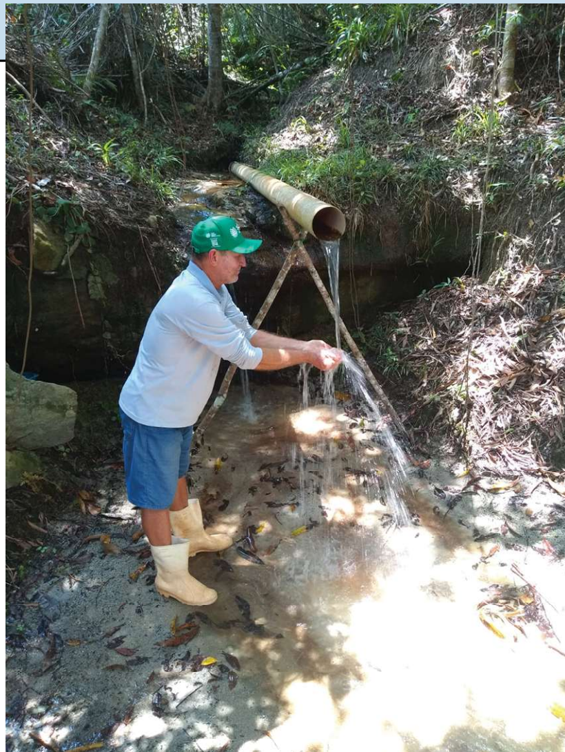
Nascente protegida no sítio São Francisco de FRANCISCO DE ASSIS ZULIANE no Km 26 da Rodovia São Mateus-Nova Venécia. Obrigado, Wellington Secundino pelo envio da foto
